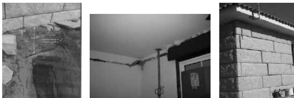
Figura 2.12. Efectos de cimentaciones sobre rellenos mal compactados
