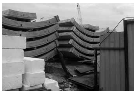
Figura 4.44. Cabeza perforadora y parque de dovelas en excavación mediante tuneladoras
