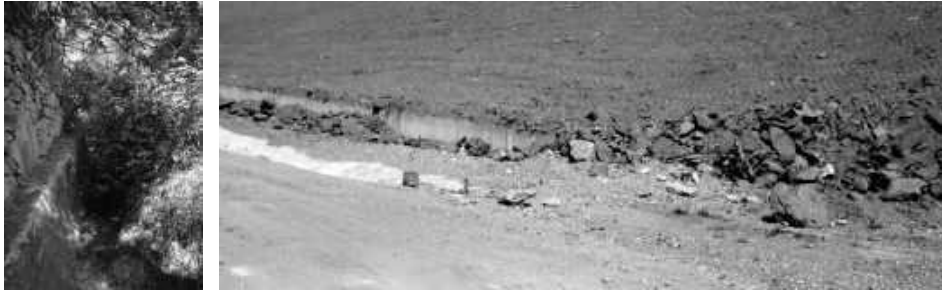
Figura 4.38. Fallos en obras de drenaje transversal
