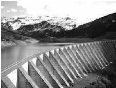
Figura 4.65. Esquema tipo de una presa de contrafuertes
