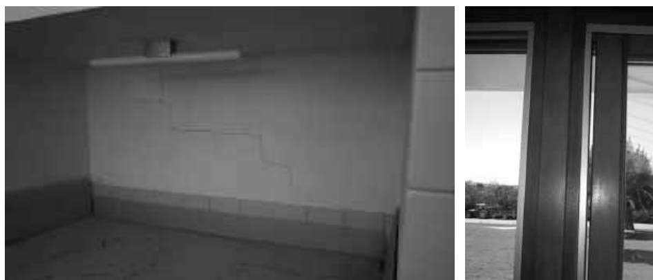
Figura 2.14. Efectos de asientos diferenciales
