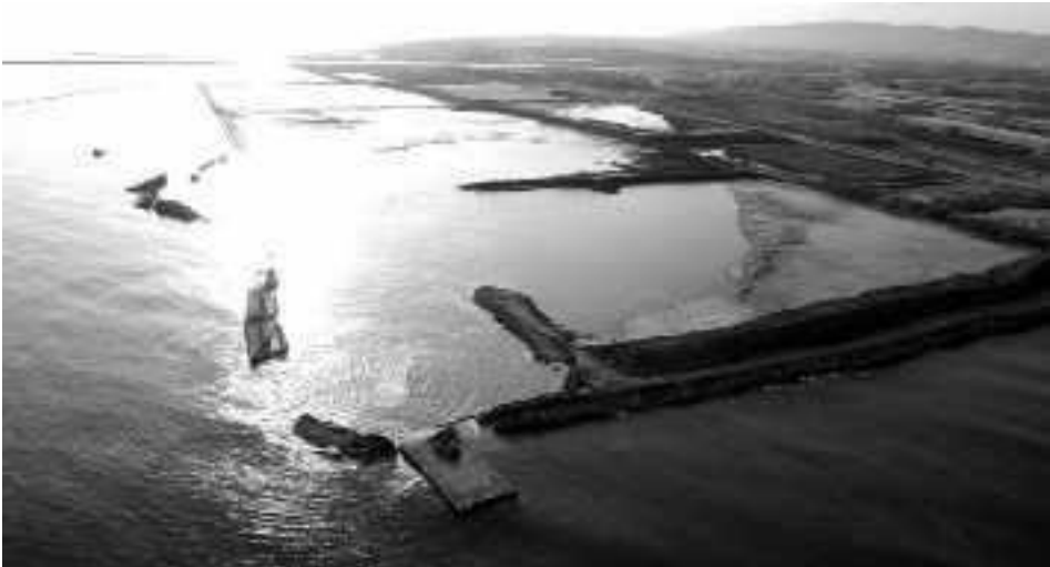
Figura 4.78. Colapso de cajones en Puerto de Barcelona
