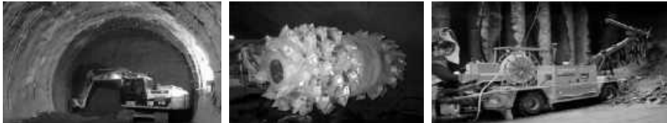
Figura 4.43. Ejemplos de perforación con excavadoras, escarificadoras o martillos jumbo
