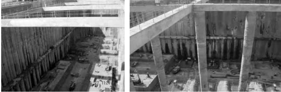
Figura 4.17. Ejemplos de estructuras provisionales de contención
