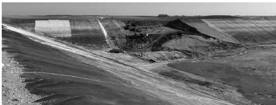
Figura 4.68. Fallo de balsa de almacenamiento de agua
