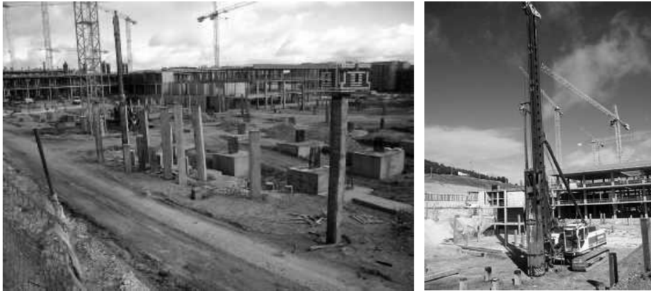
Figura 4.7. Pilotes prefabricados hincados
