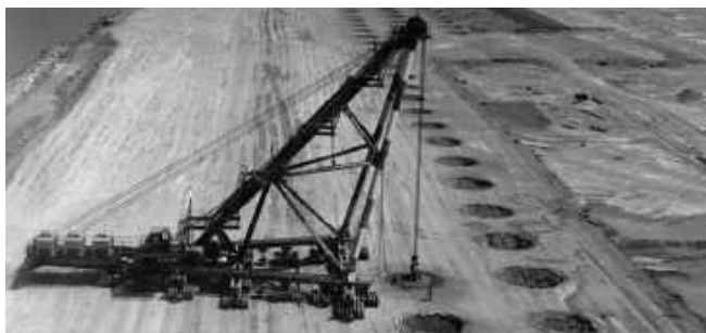
Figura 2.18. Compactación dinámica
