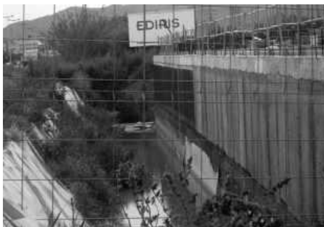
Figura 1.2. Siniestro por subpresión
