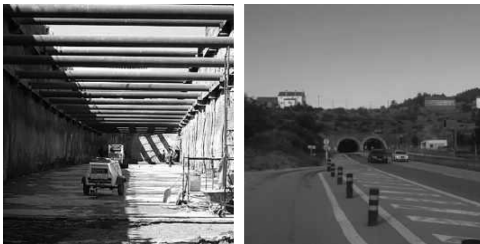
Figura 4.40. Falso túnel con pantalla de pilotes inicial (izda.) y excavación para falso túnel urbano (dcha.)
