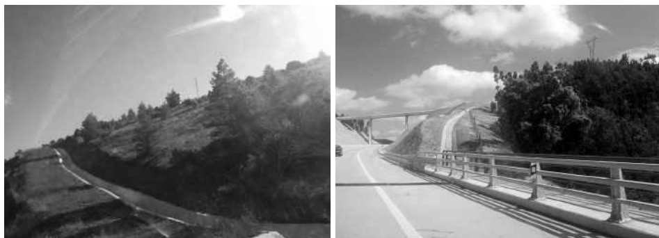
Figura 4.31. Cunetas de guarda en coronación de talud
