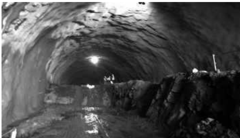
Figura 4.41. Excavación de túneles en avance y destroza
